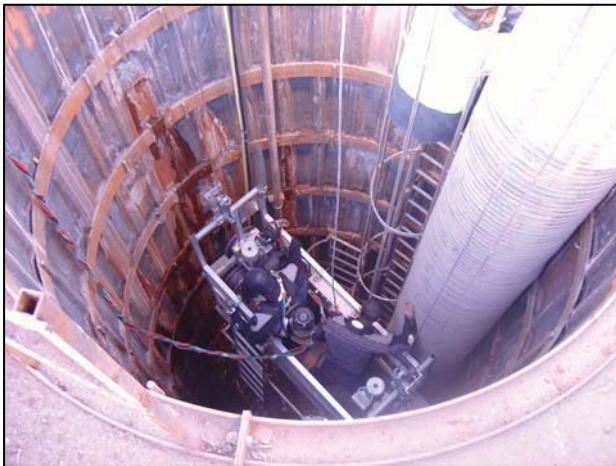
Intervention dans un puits dans le cadre d'un ouvrage d'art - Tunnel de la traversée de Toulon
