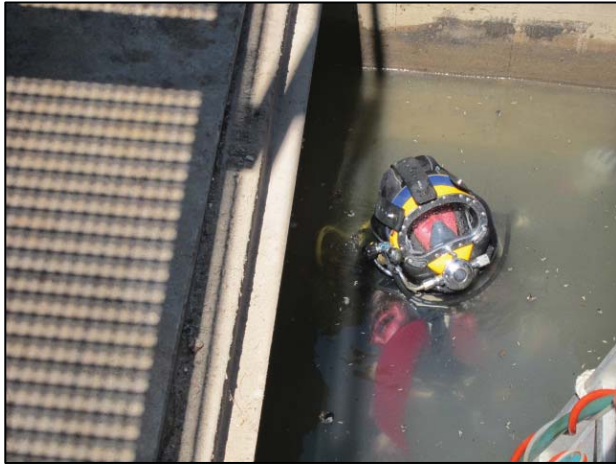
Nettoyage rainures batardeau sur barrage
